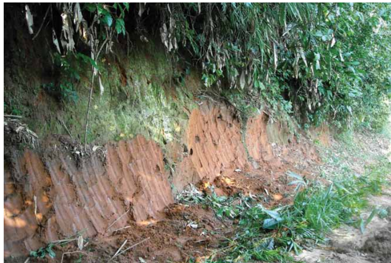
III. 14.2. Entretien de la route Mukila-Mukamba dans le secteur-chefferie Pelende-Nord. (Photo équipe locale, 2009.)
