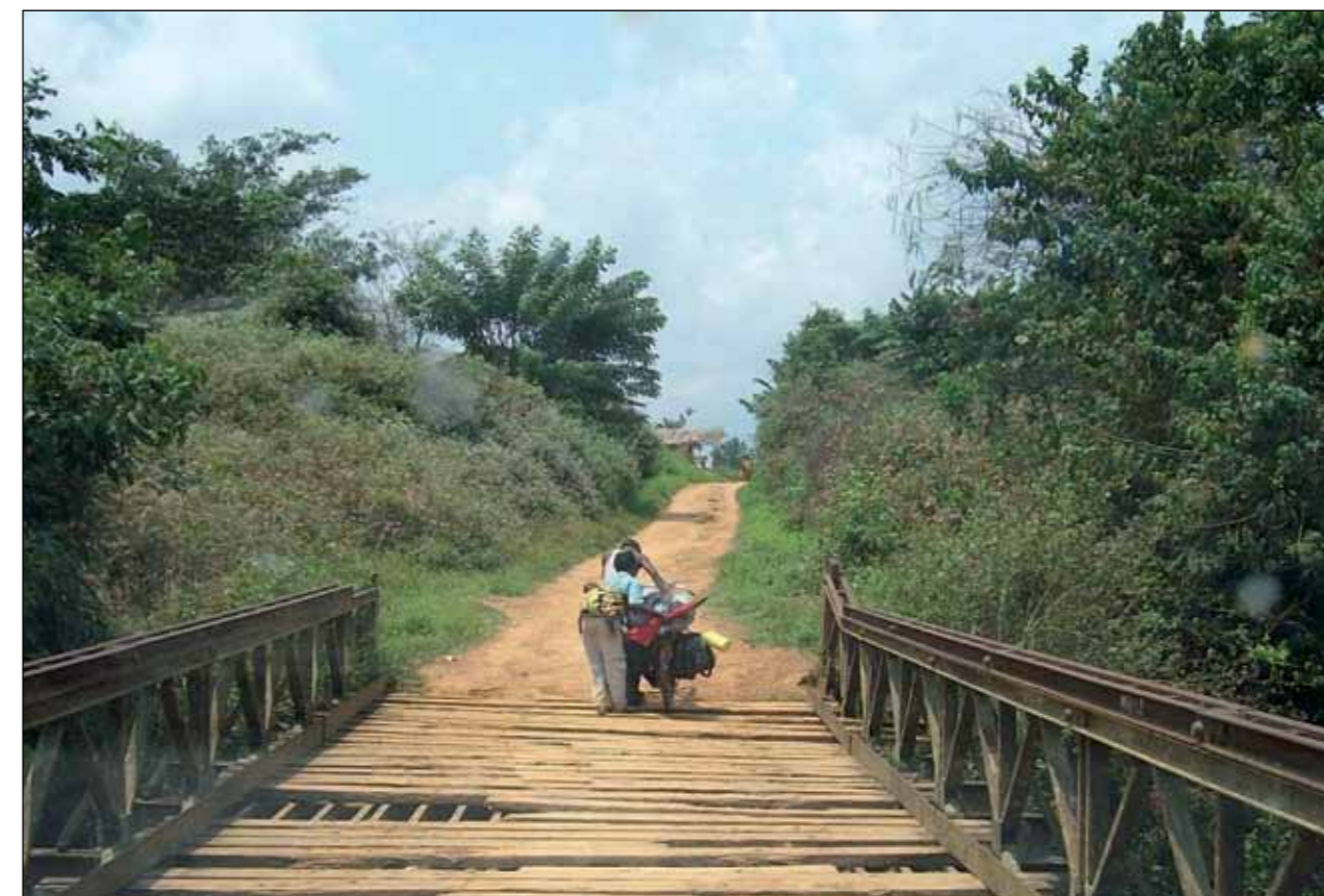
Pont de la rivière Mwanakusu sur l'axe Kayuyu - Kampene, août 2009.
